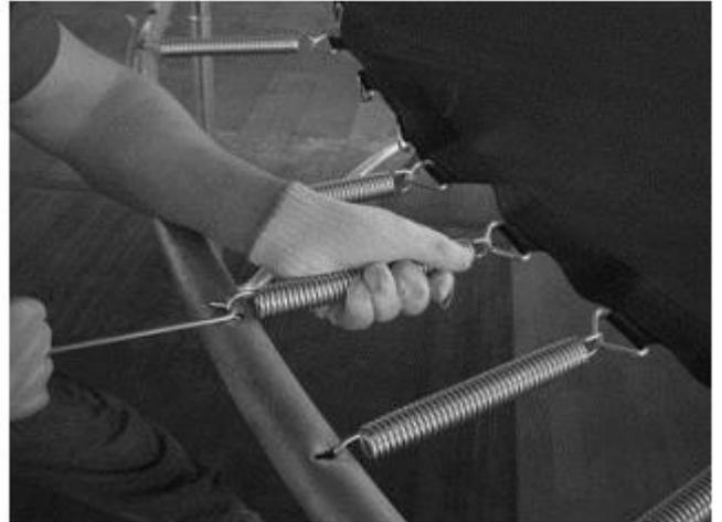
**7. Gehen Sie den ganzen Weg um das Trampolin herum und passen Sie alle verbleibenden Federn an. Stellen Sie sicher, dass die Beine in einem Winkel von 90 Grad zum Boden stehen.**
